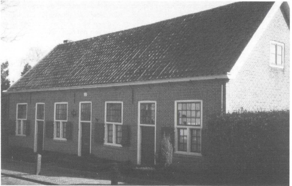
De voormalige R.K. Armenhuisjes in de huidige toestand. Boven de middelste deur is de gedenksteen zichtbaar.
